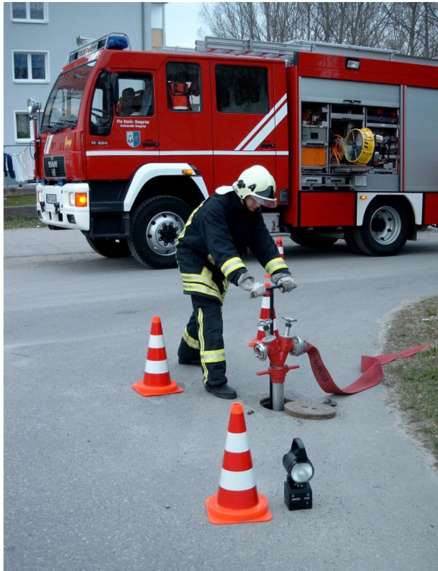
Abbildung 70: Kennzeichnung eines Standrohres (Quelle: Verfasser)
