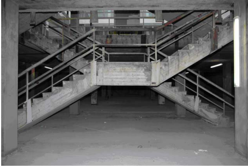
Seitenansicht der Treppe aus Richtung der Aufzugstüren
